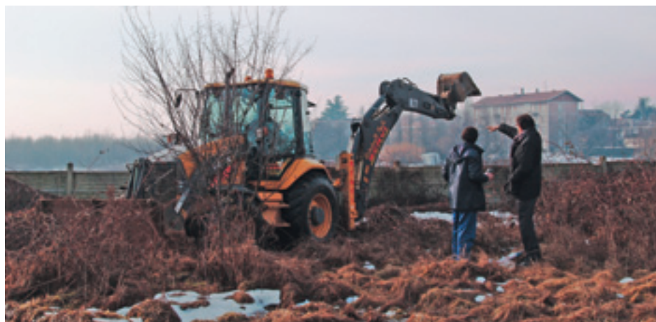
Gli interventi di sondaggio idrogeologico del terreno del nuovo ospedale in piazza d'Armi a Novara
